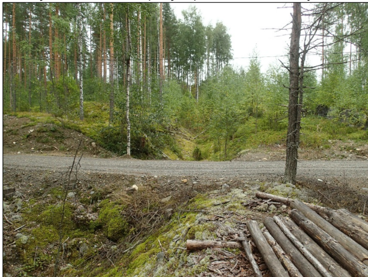
Kiviestettä ja estekaivantoa pohjoispäässä lähellä Höytiäisen rantaa.
